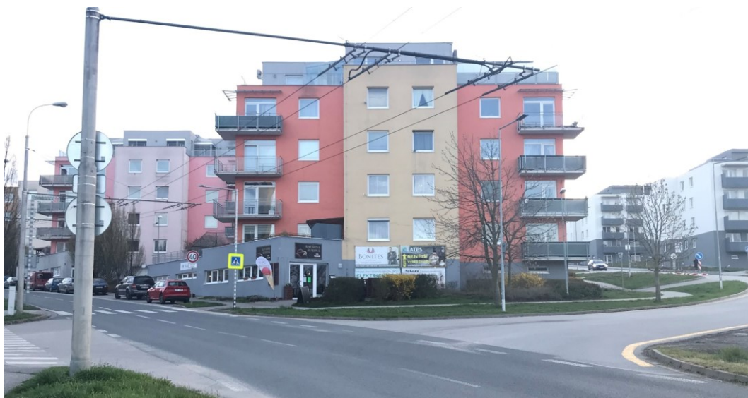
Obrázek 15 – Evakuovaný objekt. (zpracování vlastní)
