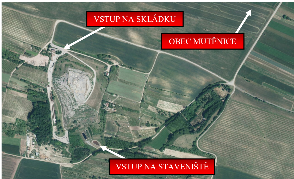
Obrázek 5 – Staveniště skládky Mutěnice – Hraničky (zdroj: iKatastr)
