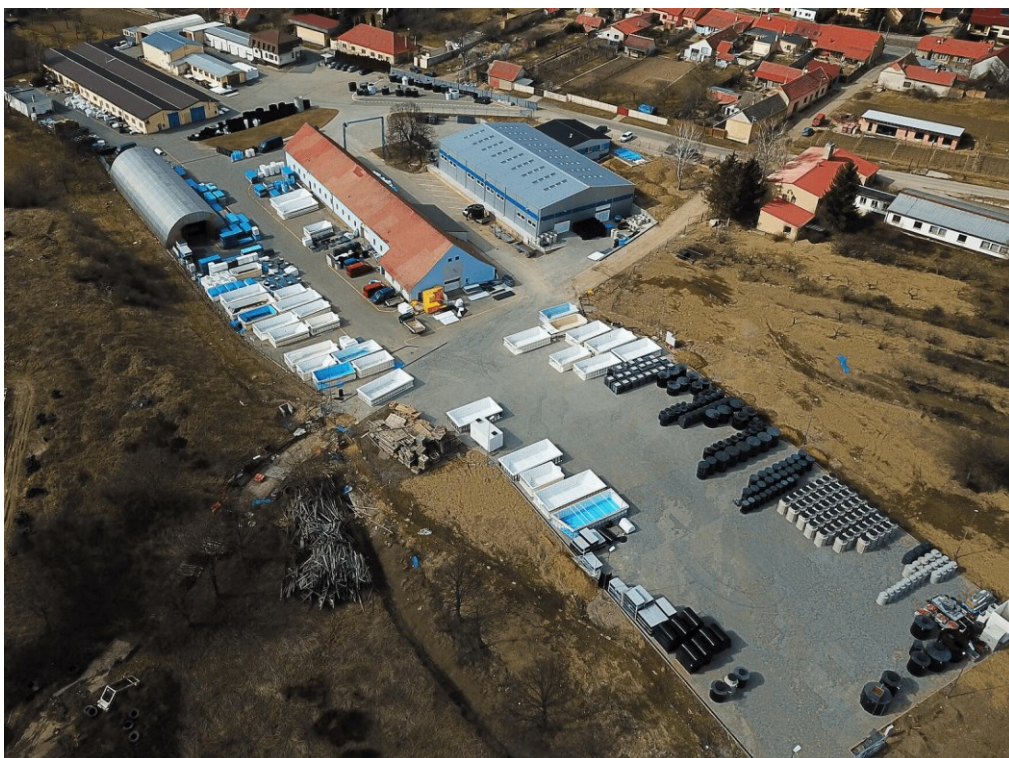
Obr. 18 Letecký pohled na společnost KELLNER CZ s.r.o.
