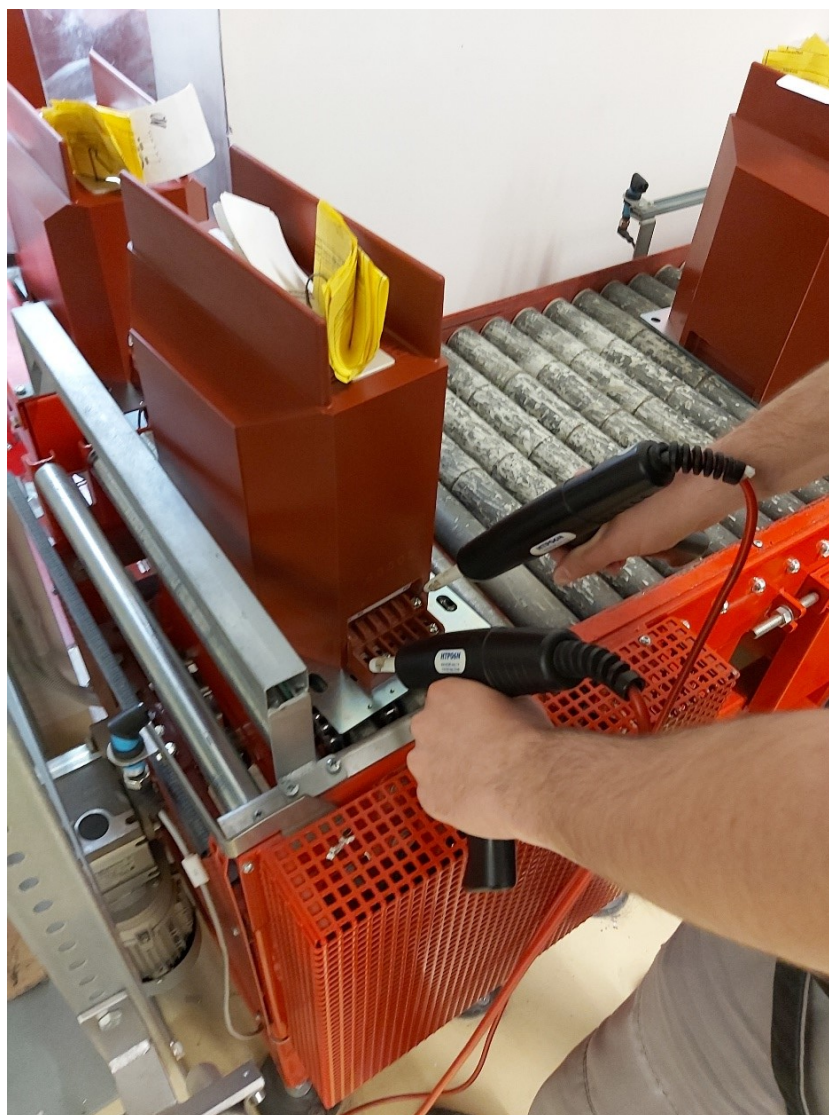
Obrázek 14. Přikládání testovacích pistolí na svorky transformátoru
