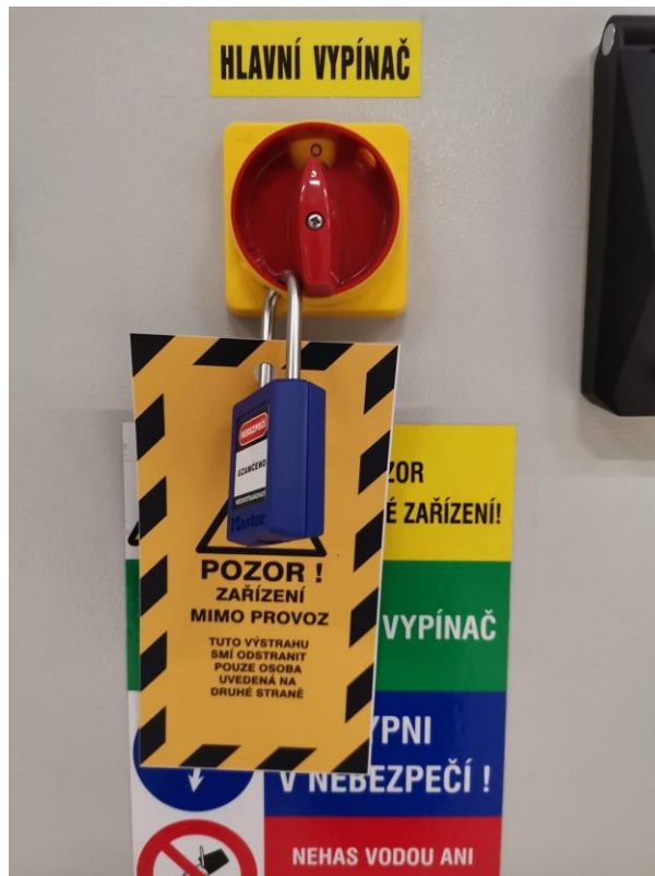
Obrázek 34 Izolování zdroje elektrické energie (vlastní fotografie)
