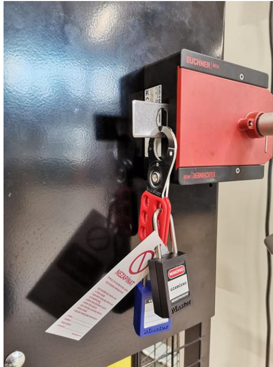
Obrázek 35 Zabezpečení linky XY během probíhající opravy (vlastní fotografie)
