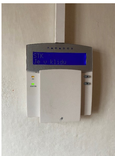
Obrázek 23. Klávesnice PZTS u vstupu do skladu [vlastní]
