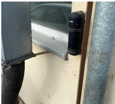
Obrázek 19. IR bariéra vně budovy emisní kontroly [vlastní]
