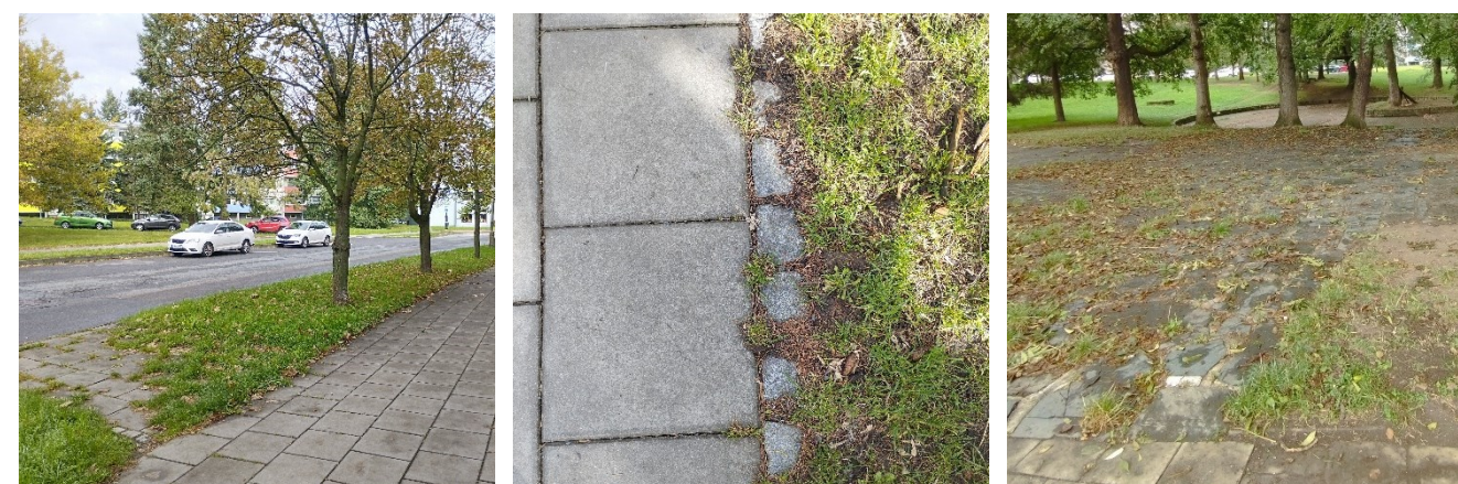
Obr. 28: Dlažba – chodník u silnice, obrubník z kostek, zarostlá kamenná dlažba [vlastní foto]
