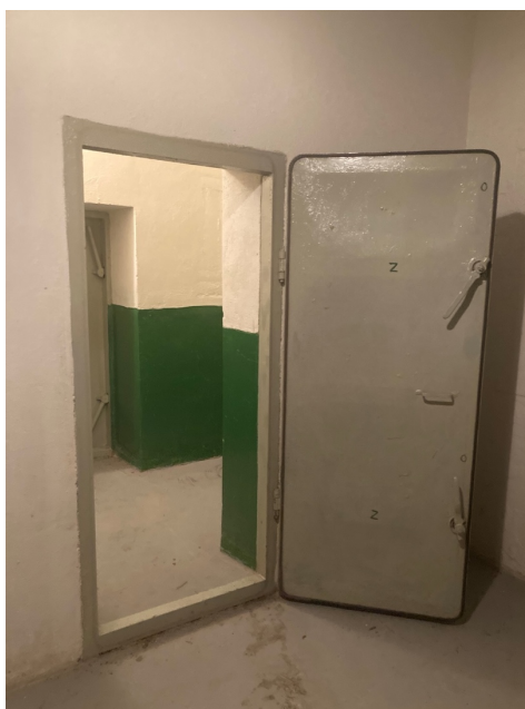
Obrázek 7 – vchodové dveře do úkrytu (vlastní)
