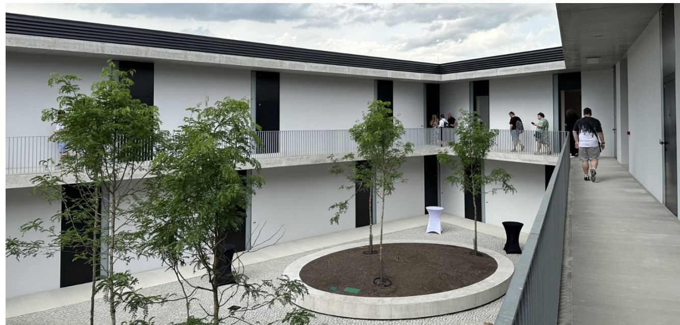
Obrázek 3 Pavlače nového bytového domu na Barrandově [12]
