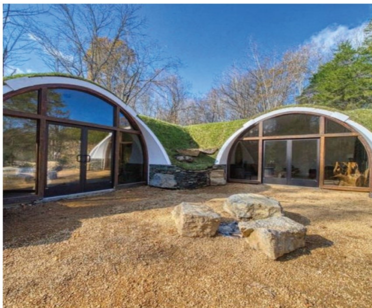
Příklad vzhledu ubytování ve svahu
