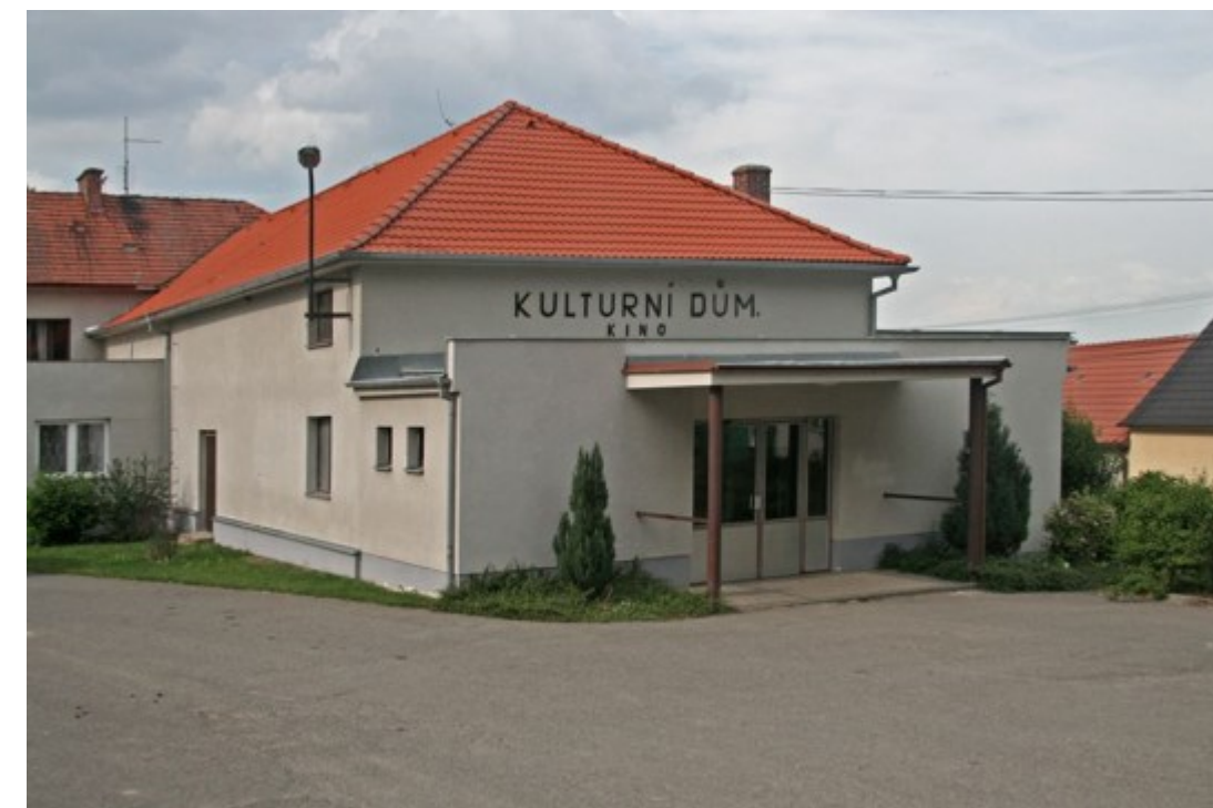
Obrázek 8 Ukázka typického vesnického kulturního domu (zdroj: Obec Radětice, 2016)
