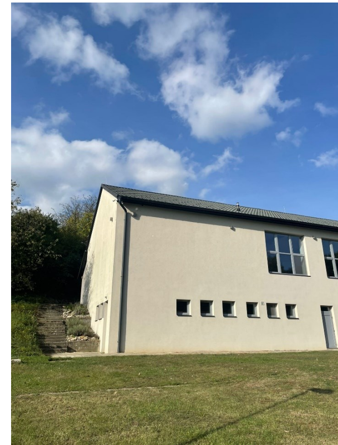
Obrázek 37 Pohled na kulturní dům a chátrající schodiště (zdroj: vlastní zpracování, 2023)
