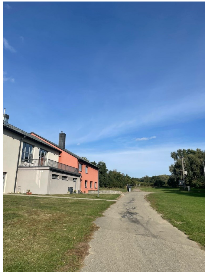
Obrázek 35 Pohled od hlavní komunikace na kulturní dům (zdroj: vlastní zpracování, 2023)
