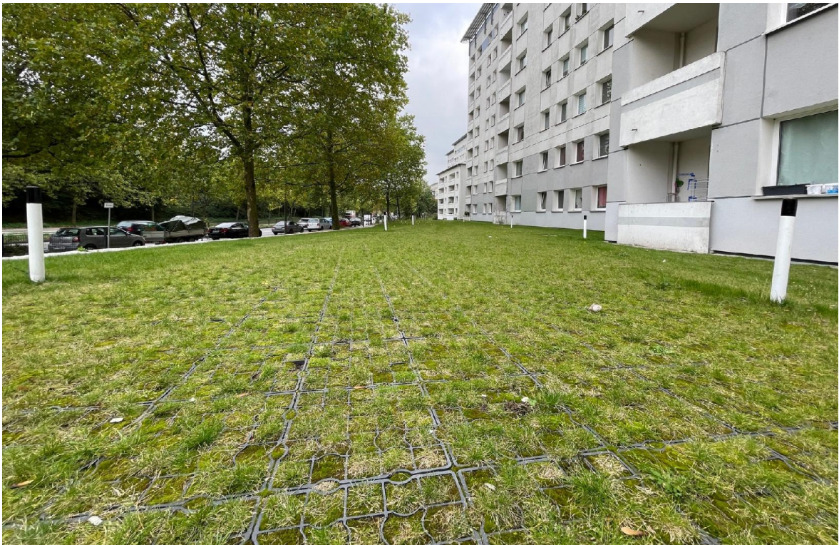
Obr. 41 – Nástupní plocha požární techniky ze zatravnovací dlažby v Hamburku (Gál, 2024)
