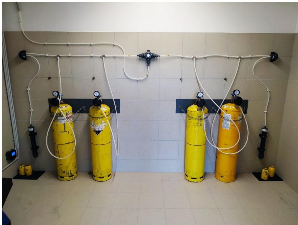
Obrázek 5 Připojené láhve s chlorem (vlastní, 2024)
