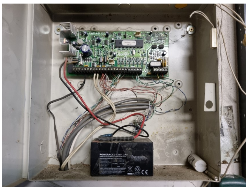
Obrázek 12 Snímek instalovaného PZTS [vlastní]
