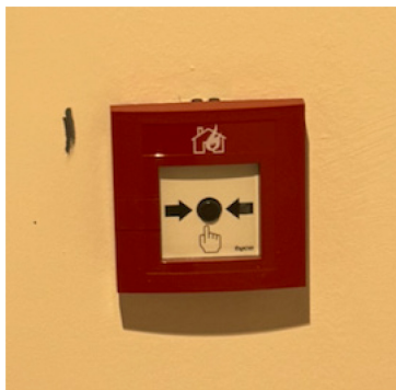
Obrázek 9_Manuální hlásič požáru [vlastní]
