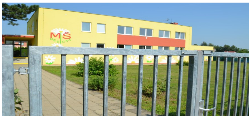
Obrázek 6 Vstup 1 (zdroj: vlastní)
