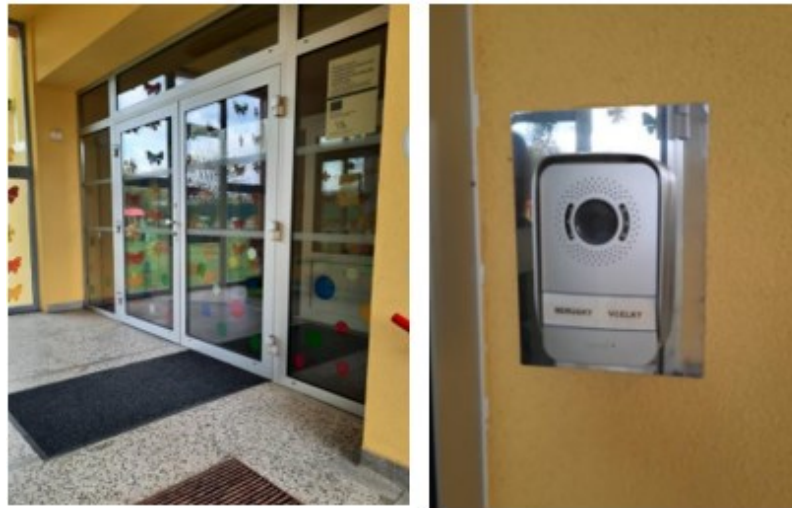
Obrázek 9 Hlavní vstup č. 3 (zdroj: vlastní)
