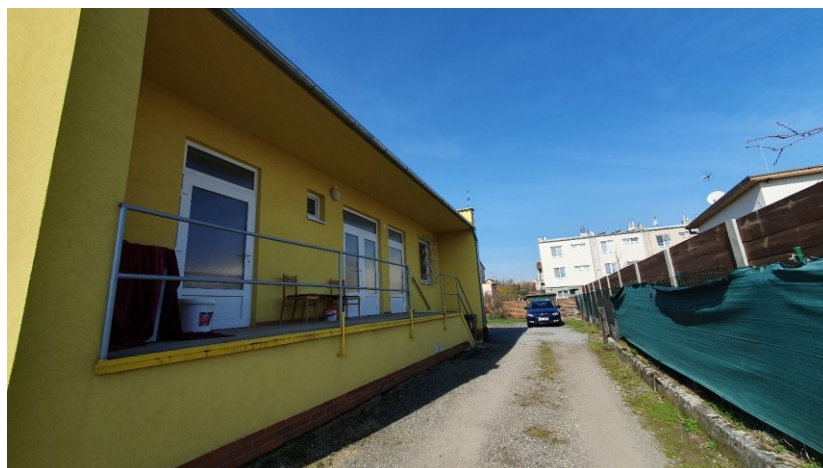
Obrázek 10 Vstup č. 4 zásobování (zdroj: vlastní)
