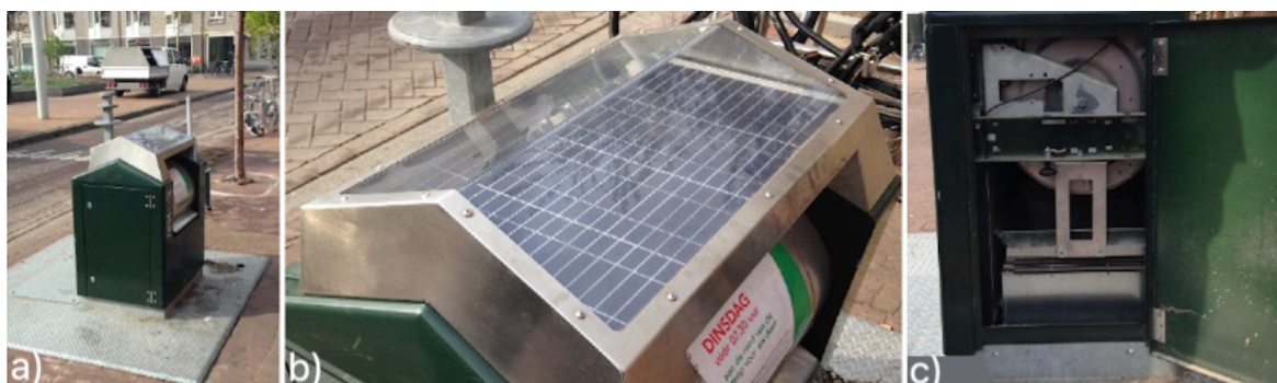
Obr. 7 Podzemní kontejner a); solární panel b); lis c) (Vlastní zpracování, 2024)
