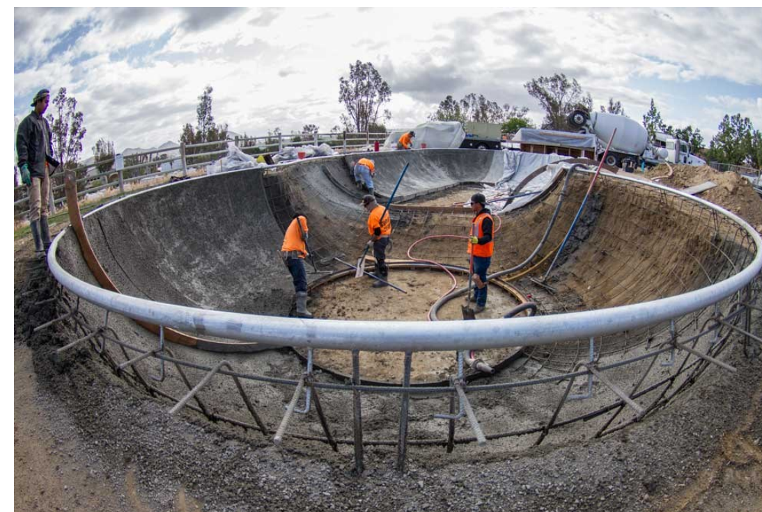
Obrázek 4 Konstrukce vany skateparku (Skatepark Building in Lake Elsinore, California, 2015)
