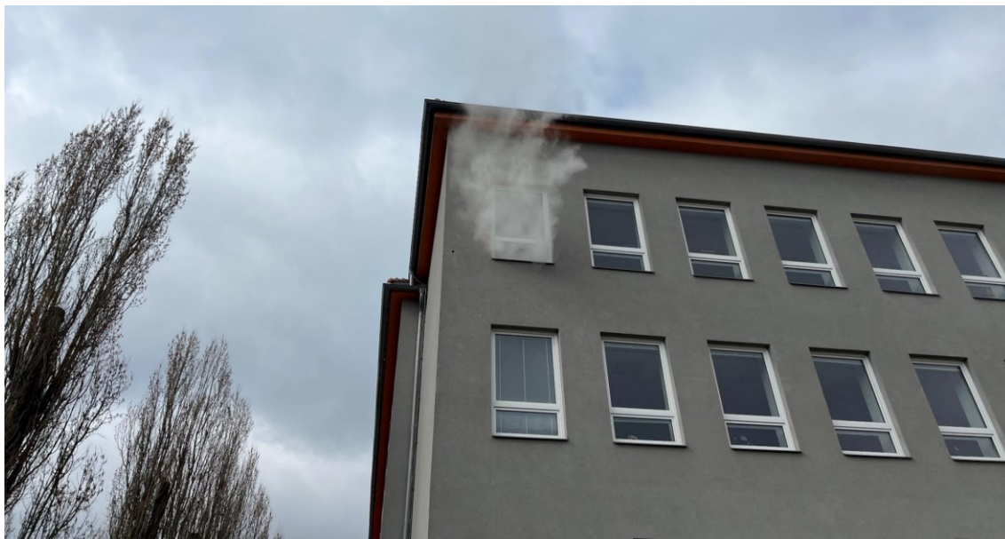
Obrázek 18 – Detail na hořící budovu ve druhém nadzemním podlaží (vlastní)
