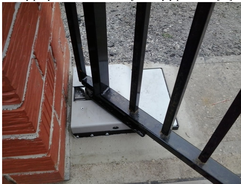
Obrázek 15 Podzemní pohon [19]
