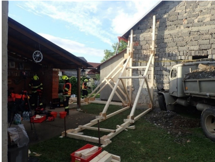
Obrázek 20 Stabilizace Racková (HZS ZLK)
