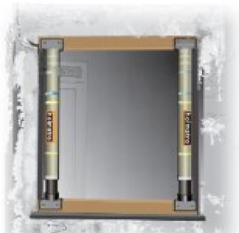
Obrázek 14 Stabilizace okna systémem Holmatro (Morris, 2008)
