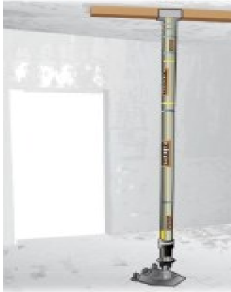
Obrázek 13 Bodová stabilizace pomocí stabilizační vzpěry (Morris, 2008)
