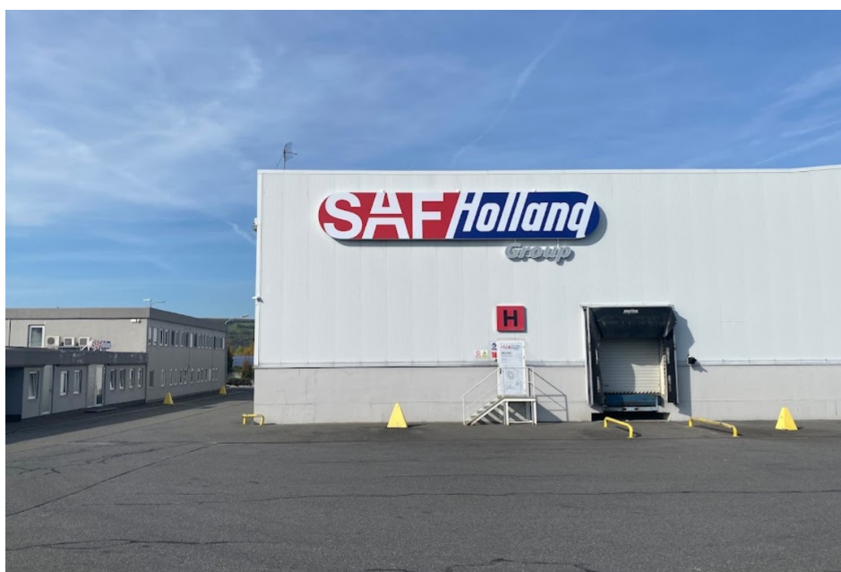
Obrázek 8 Skladová hala SAF-HOLLAND Czechia spol. s r.o. (vlastní zdroj)
