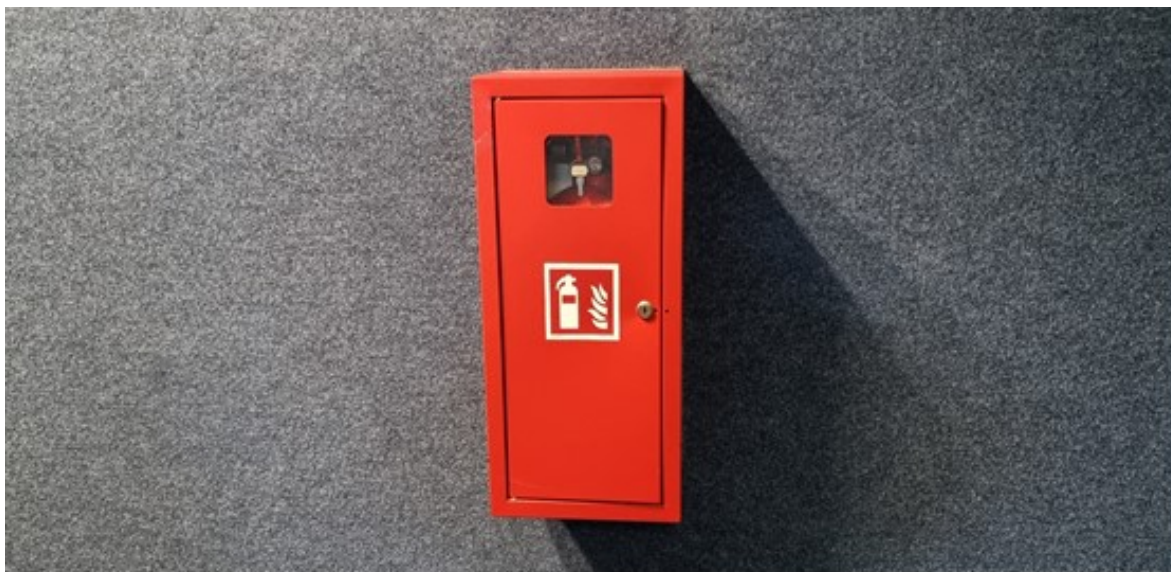
Obr. 13 – Hasicí přístroj práškový umístěný na zdi ZS (Vlastní).
