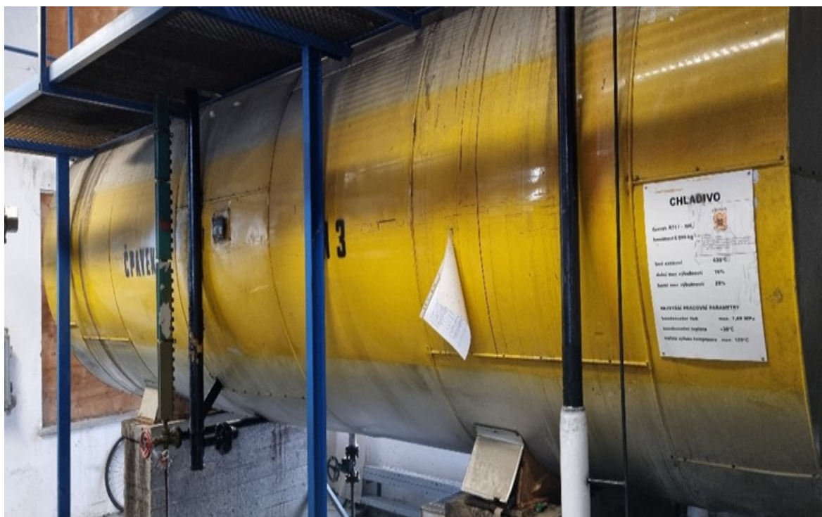
Obr. 7 – Tlaková nádoba na amoniak (Vlastní).
