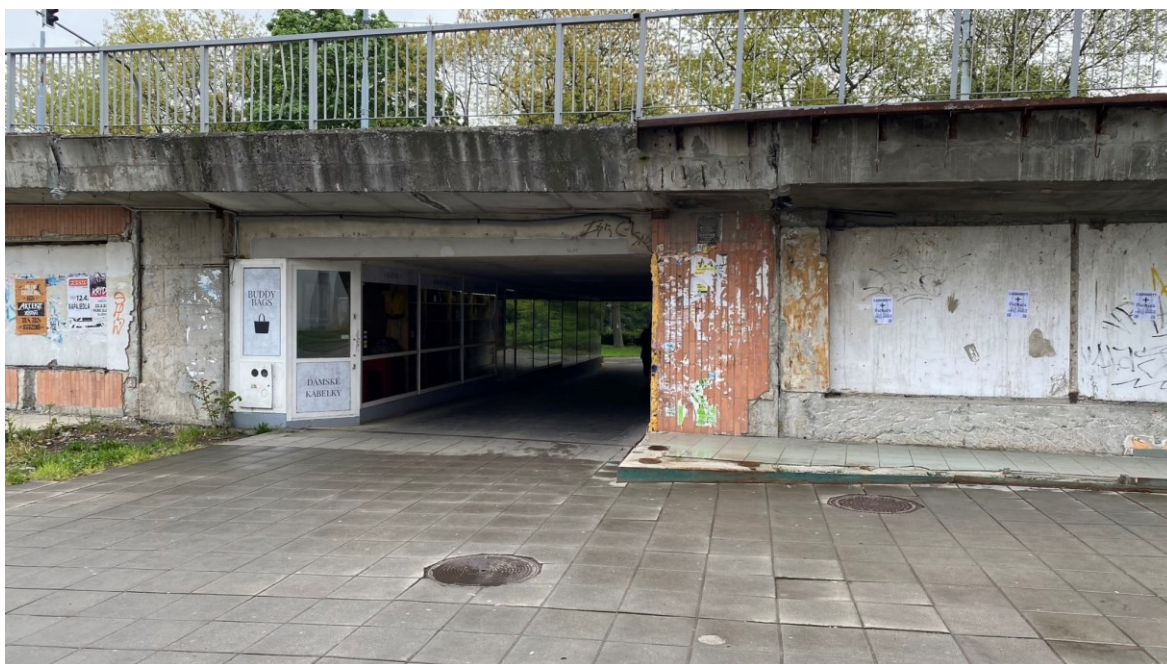
Obrázek 10 podchod od autobusového nádraží – autorova fotografie
