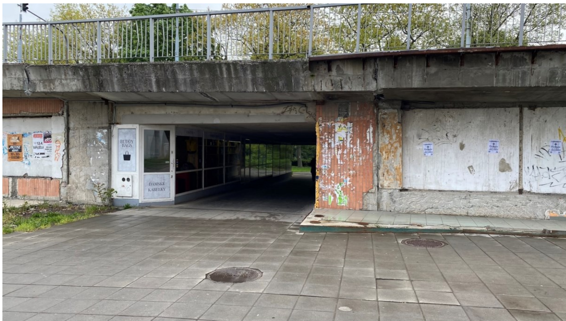
Obrázek 22 hlavní podchod, současný stav – autorova fotografie
