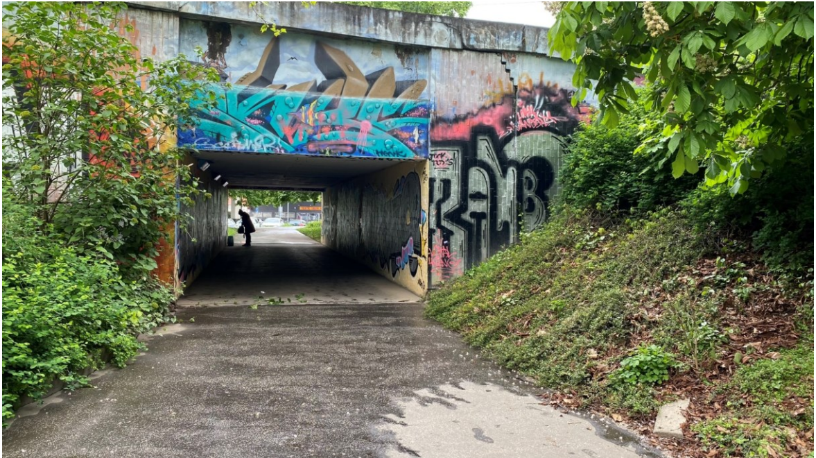
Obrázek 24 vedlejší podchod, současný stav – autorova fotografie
