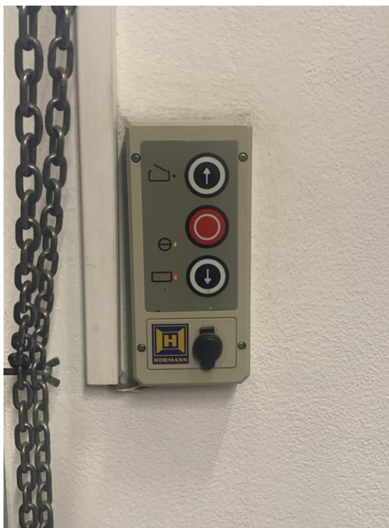
Obrázek 14 Tlačítka pro ovládání vrat a řetěz pro ruční vytažení [vlastní]
