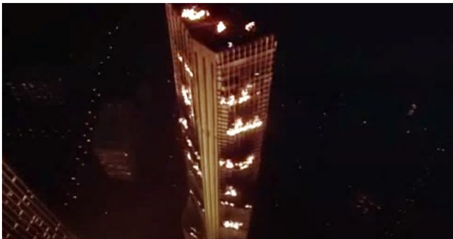
Obrázek 1 Budova zasažena požárem (Zdroj Guillermin, 1974)
