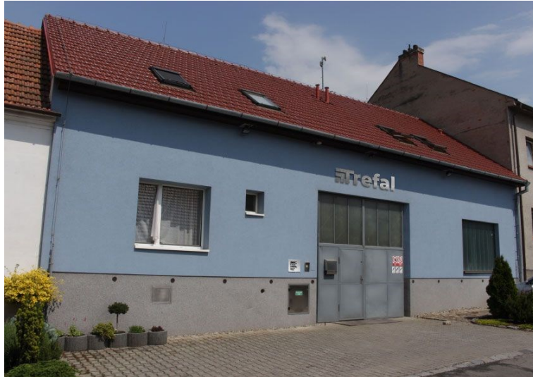
Obrázek 9: Sídlo společnosti (Trefal, ©2024)
