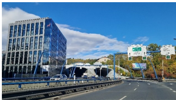
Obrázek 14 - Ochranný systém podzemních dopravních staveb Strahovského tunelu, Praha. (Vlastní, 2023)
