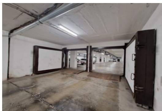
Obrázek 15 - Prostory improvizovaného úkrytí podzemních garáží Hony I, Zlín. (Vlastní, 2023)
