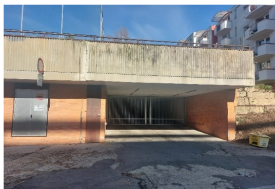
Obrázek 20 - Vjezd do podzemních garáží SÚCO. (Vlastní, 2023)
