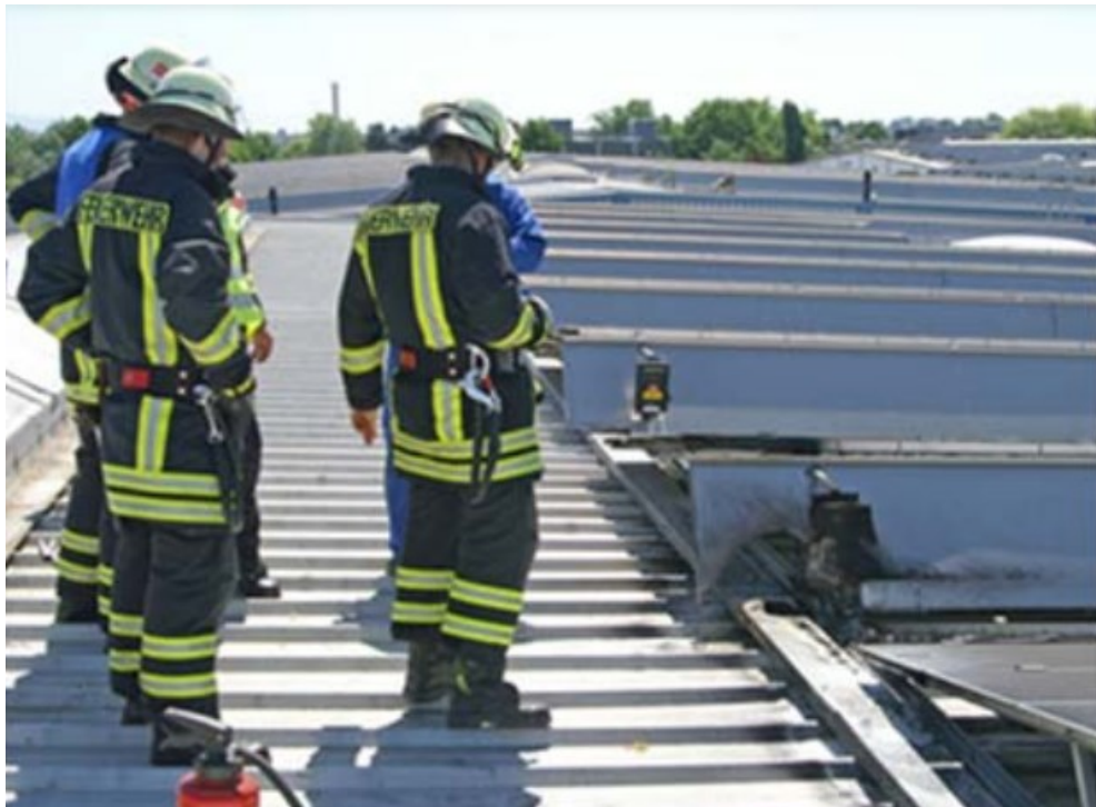
Obrázok 18 – miesto požiaru FV systému so zhorenou zlučovacou skrinkou [44]
