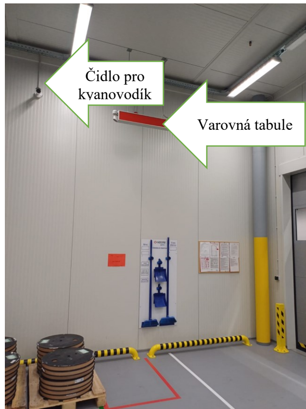
Obrázek 10 Čidlo na zachycení kyanovodíku a varovná tabule (zdroj: Vlastní, 2024)
