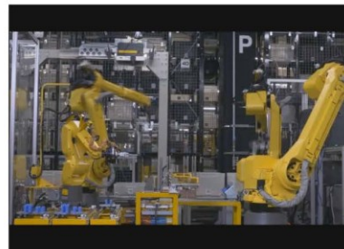
Montáž CNC systémů
