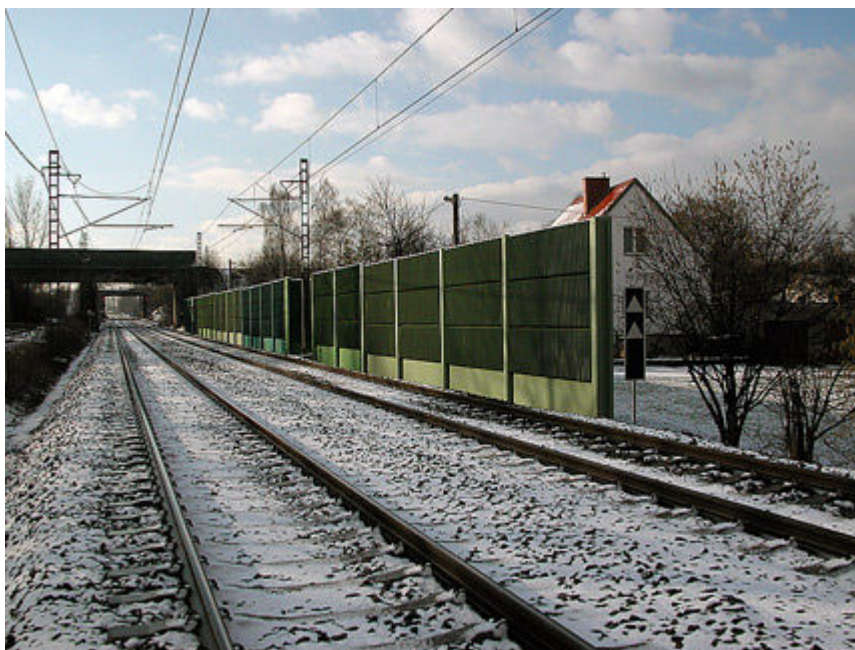
Obrázek 5. Protihluková stěna u železnice
