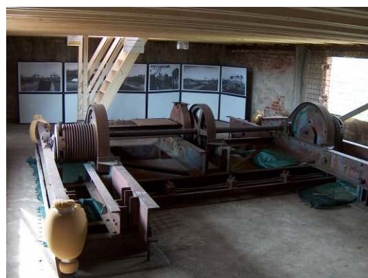
Obr. 7 Zařízení uvnitř Výklopníku na vyzdvižení zadní části vagónu.
