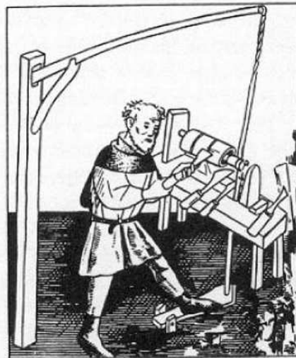
4. Soustruh se šlapadlem
