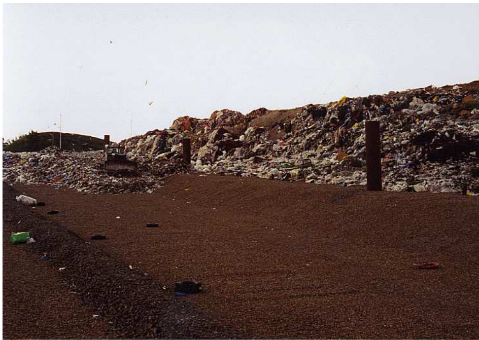
Obr. 2 Systém odplynění skládky Suchý důl - II etapa
