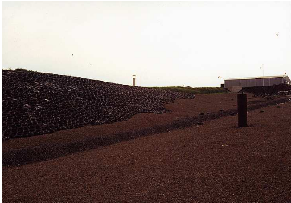
Obr. 1 Systém odplynění skládky Suchý důl - II etapa (2002)
