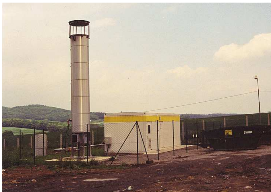
Obr. 5 Zařízení na jímání, sledování kvality a množství skládkového plynu - Suchý důl
