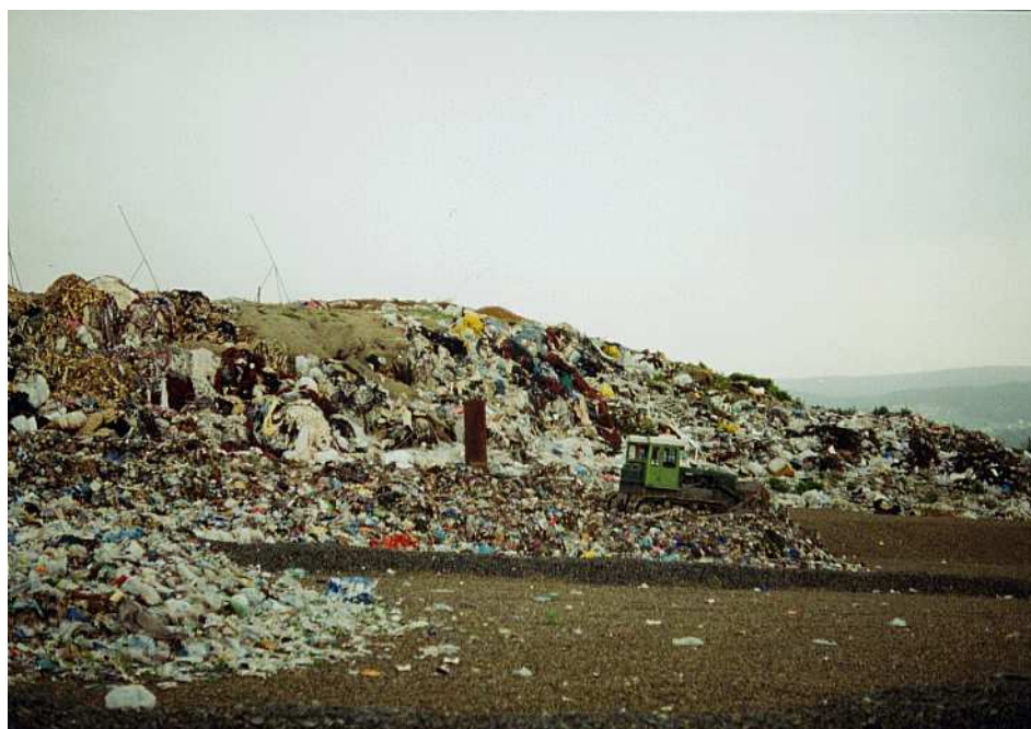
Obr. 4 Systém odplynění skládky Suchý důl - II etapa
