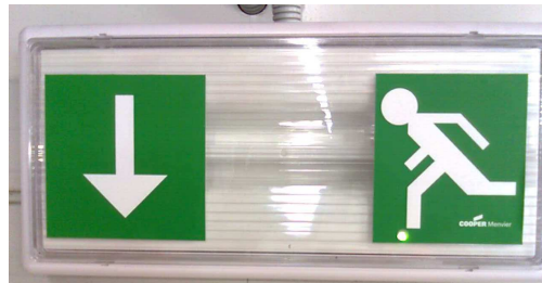
nouzové osvětlení obr. 1 1
