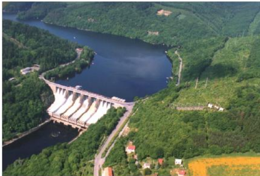
Obrázek 3: Vodní elektrárna Slapy na Vltavě (letecký pohled) [6]
